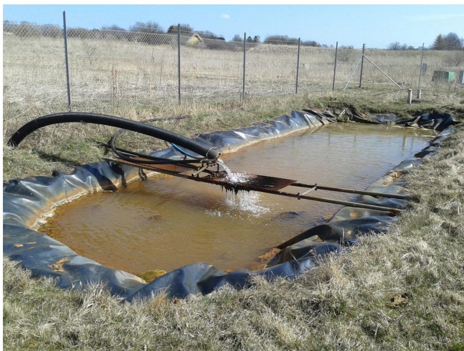
Foto 1. Brændstofdepot N - Beluftning af oppumpet grundvand ved bassin.
