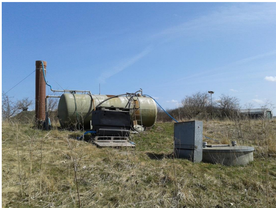
Foto 2. Brændstofdepot SV - Beluftningstank og -tårn.
