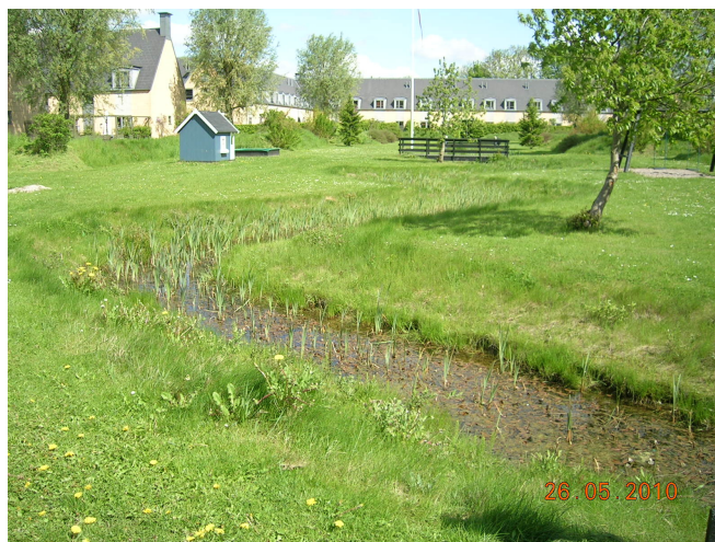
Regnvandsløsning i Jonstrup
